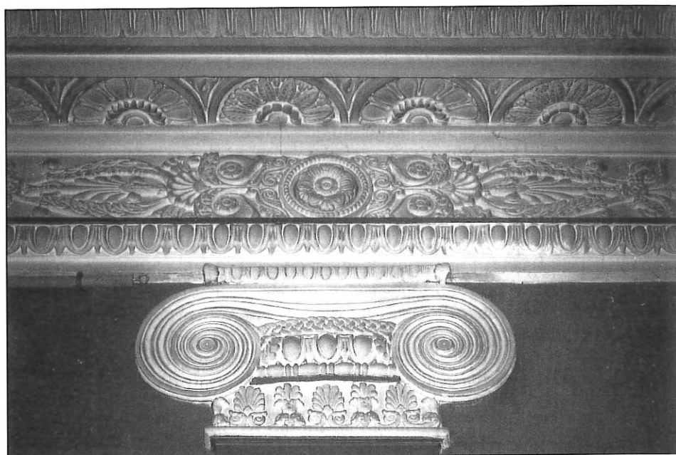
7. Salon 3, detail van de overgang tussen wanden en plafond, fries gedragen door pilasters met Ionische kapitelen, 1996 (Foto R. Müller).
