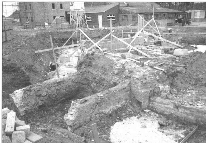
1. Zicht op de funderingen van de toegangsbrug tot het neerhof van Diepensteyn, met daarachter nog een zicht op de nu verdwenen gebouwen van de vroegere landbouwuitbating (Foto: H. van Royen, augustus 1994)
